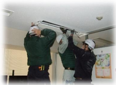
【三勇ビル 交換作業写真】
